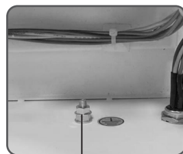
Болт заземлення (підключення РЕ)
